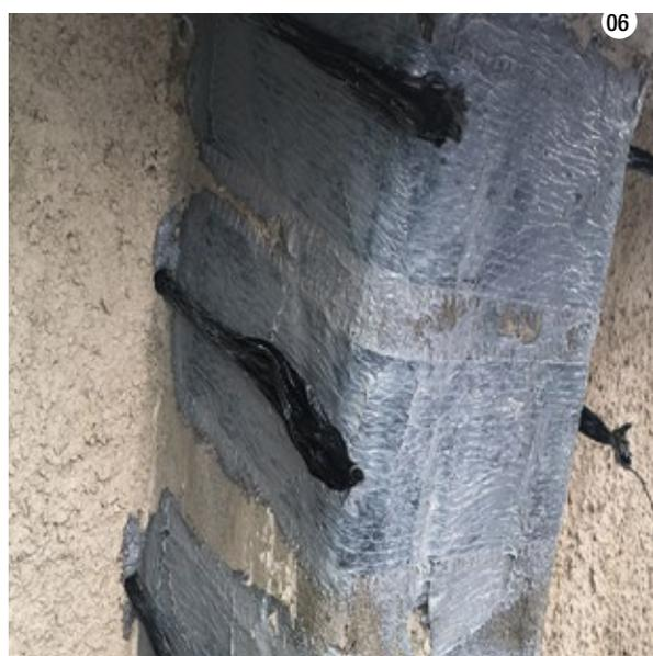
epossidico Sikadur®-330, in avvolgimento ad anello chiuso o di tessuto unidirezionale in fibra di carbonio ad alta resistenza, opportunamente ancorate alla soletta soprastante con corda unidirezionale in fibra di carbonio SikaWrap® FX-50C, diam. 8 mm.;
