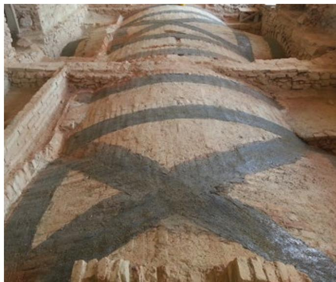
tessuti in CFRP consente, infatti, di modificare il meccanismo di rottura della volta originaria, permettendo, in tal modo, un incremento anche notevole del moltiplicatore di collasso.
