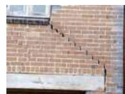
Fessure di murature provocate da un cedimento delle architravi.
