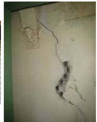
Fessura ad arco di una muratura provocata da un cedimento della fondazione.
